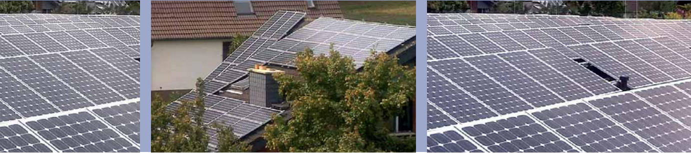
Auf einem Dach in Osnabrück
